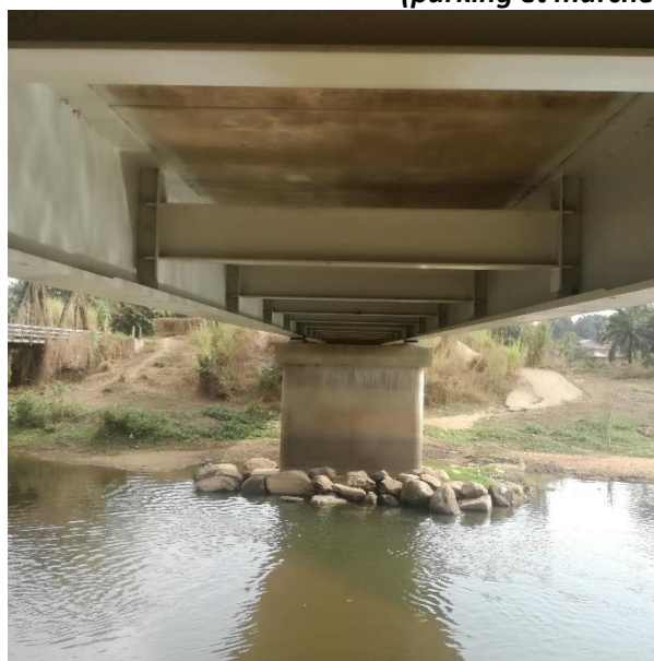
OA10- Pont bipoutres mixtes à 2 travées de 32 m (PK56+370)
