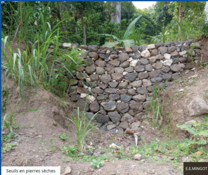
Seuils en pierres sèches
