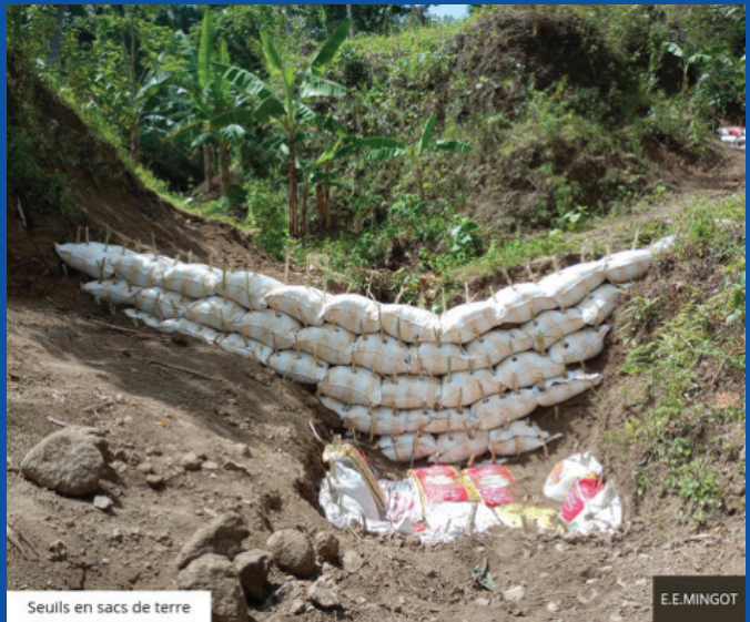
Seuils en sacs de terre
