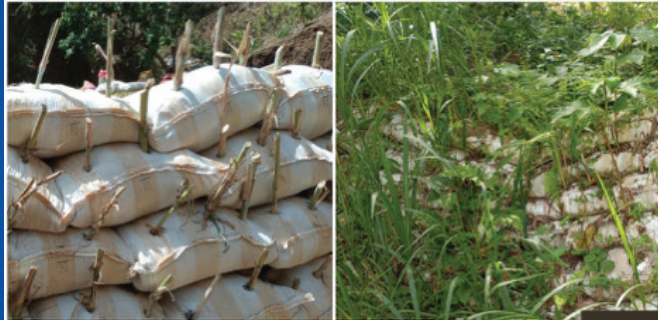
Napiers ou herbes à éléphant implantés dans les sacs de terre
