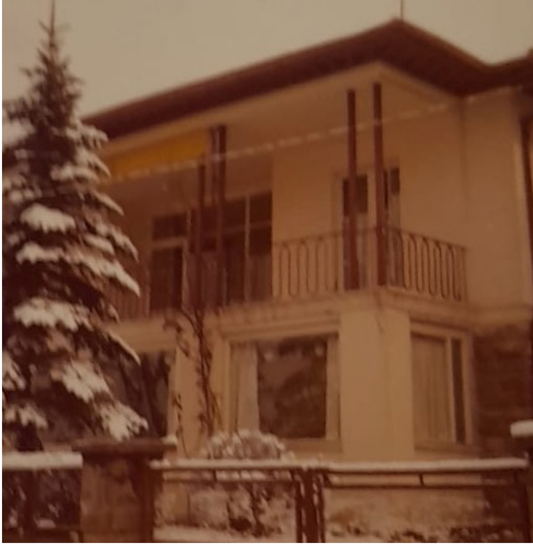
Basın ve Enformasyon Bürosu'nun ilk binası Çankaya, Boğaz Sokak No:13 adresinde yer alıyordu
